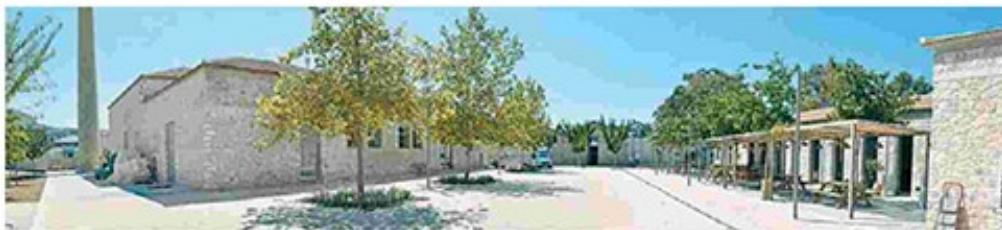
Το «διατηρητέο» συγκρότημα των τριών πέτρινων κτιρίων, του Αίθριου του «Φουγάρου», ως κατασκευαστικό έργο ανάπλασης και αποκατάστασης, φέρει την υπογραφή των αρχιτεκτόνων Μόρφως Παπανικολάου και Ρένας Σακελλαρίδου.
